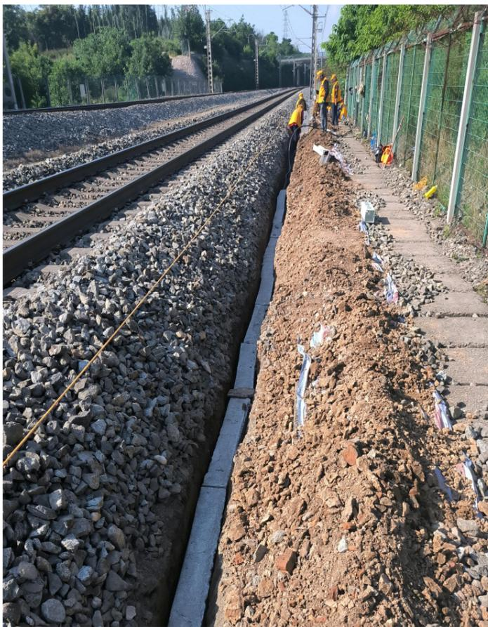
正值烈日当空，高温酷暑天气，现场作业人员不畏酷暑，克服既有线施工的重重困难，主动出击，抢时间抢工期，历时15天，K33+500至K34+000上下行区段共计1公里光电电缆摸排、开挖缆沟、敷设光电电缆、径路回填恢复及6条光电电缆割接全部完成。6月
